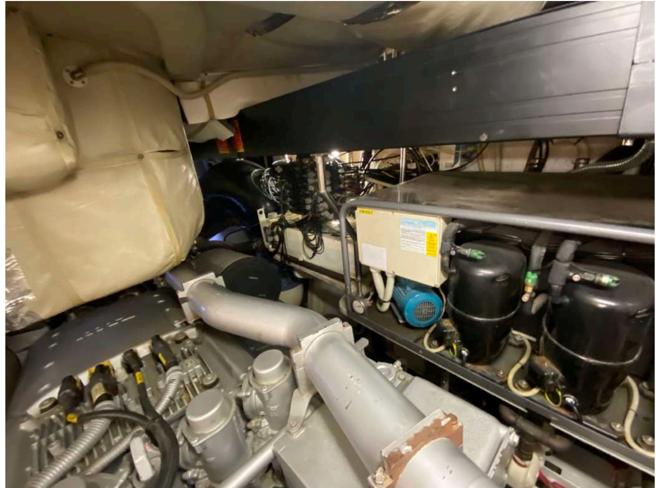
Dettagli della sala macchine che monta due Motori MTU da 1.823
